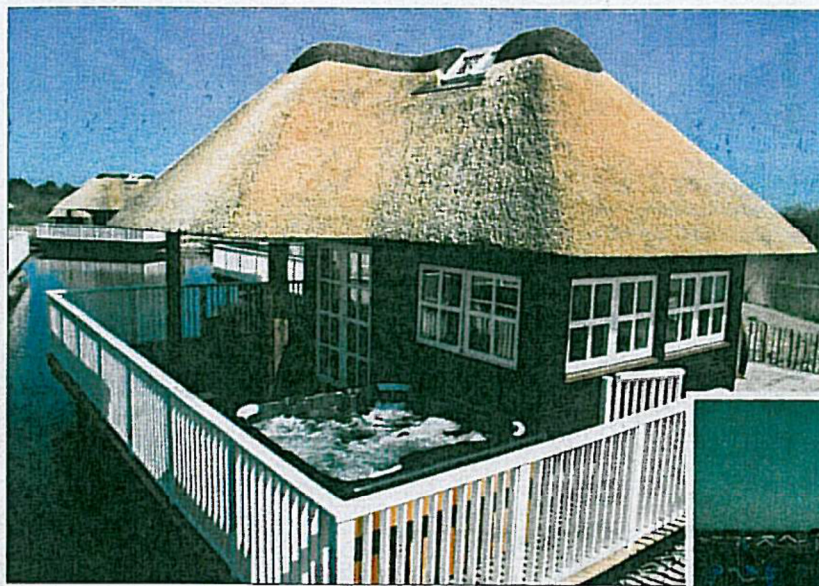
Det er 21 nye fiskerhytter som denne, der er under opførelse på Hvidbjerg Strand Feriepark.
